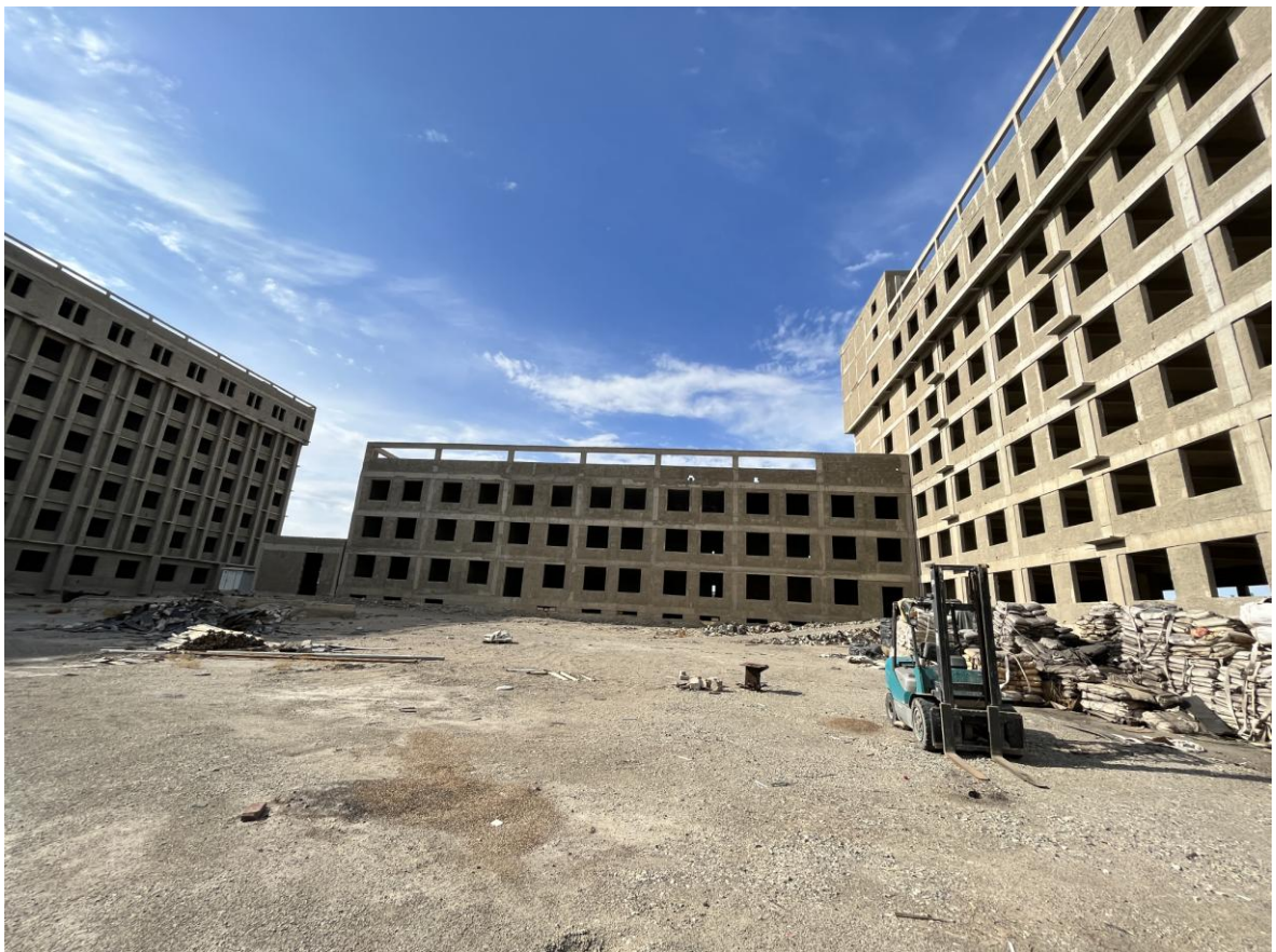
现场勘查照片
